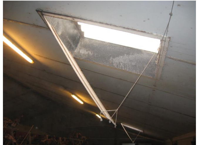
Figura 1: Las entradas de luz natural también se pueden gestionar para controlar la cantidad de luz que entra en la nave (Fuente: WUR).
