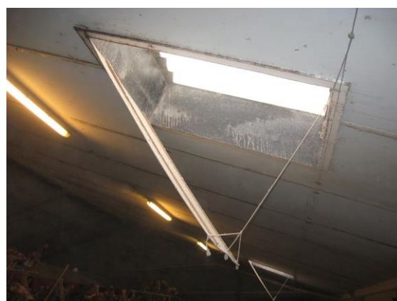
Figure 1: Les entrées de lumière naturelle peuvent également être gérées pour contrôler la quantité de lumière entrant dans le poulailler (Source : WUR).
